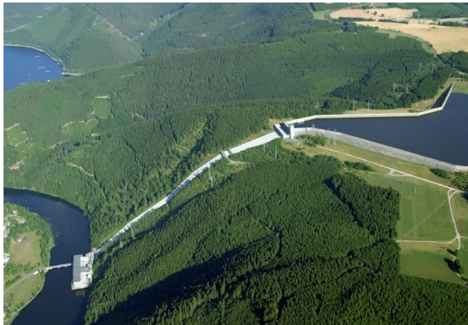
Figure 2 – Hohenwarte II hydroelectric plant (Vattenfall, 2026).
